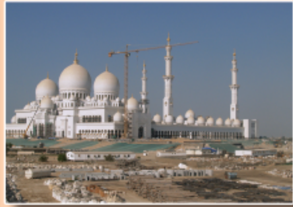
Mezquita dubaití, en construcción.
